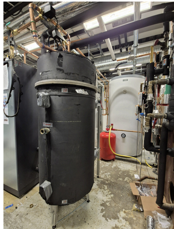
Figure1: Sous-système de stockage de l'énergie thermique du HESS (Stockholm, Suède)
