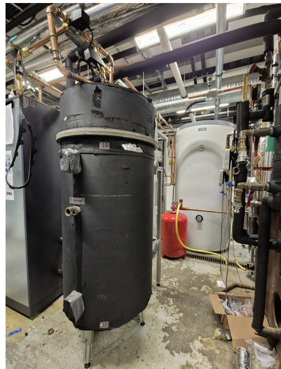
Figur 1: Termisk energilagringssystem av HESS (Stockholm, Sverige)
