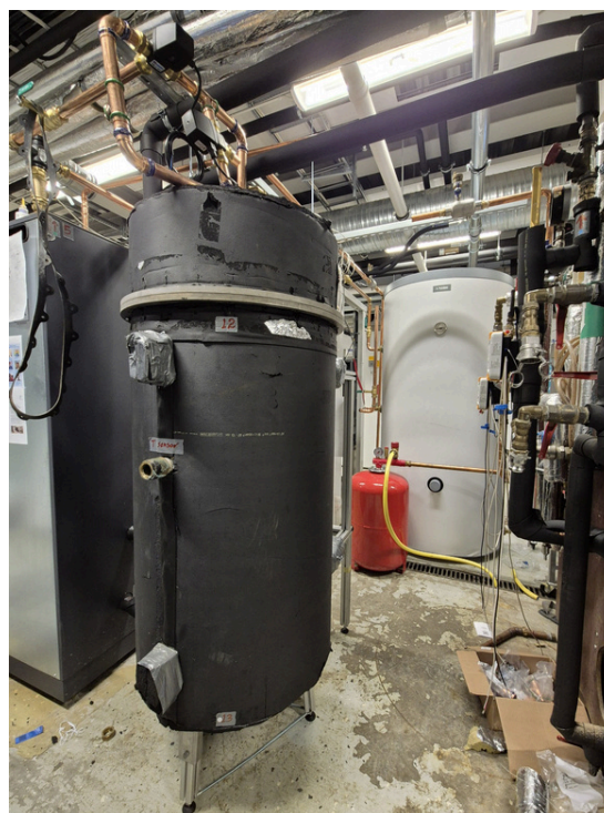
Figura1: Sottosistema di accumulo di energia termica dell'HESS (Stoccolma, Svezia)
